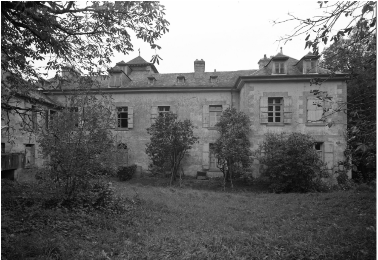
Elévation nord, vue générale.
