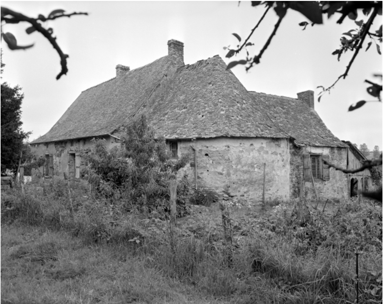
Elévation sud-est, vue générale.
