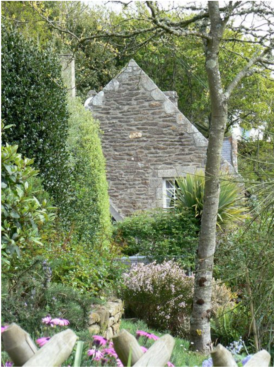
Pignon sud-ouest de la maison Beg Roudou
