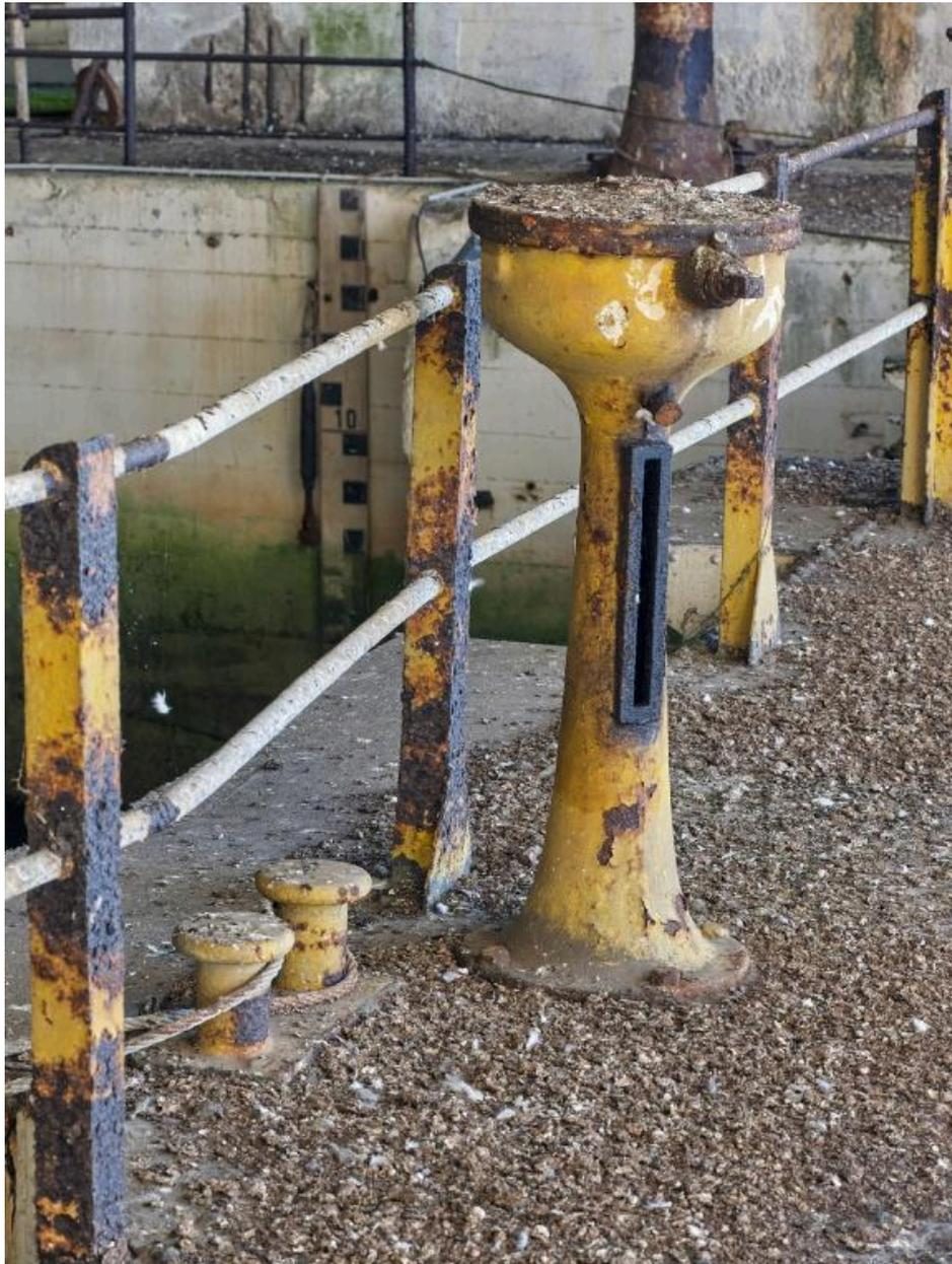
Vue de l'une des deux commandes de pompe sur le bateau-porte fermant le bassin. Elle fonctionnait avec une manivelle
