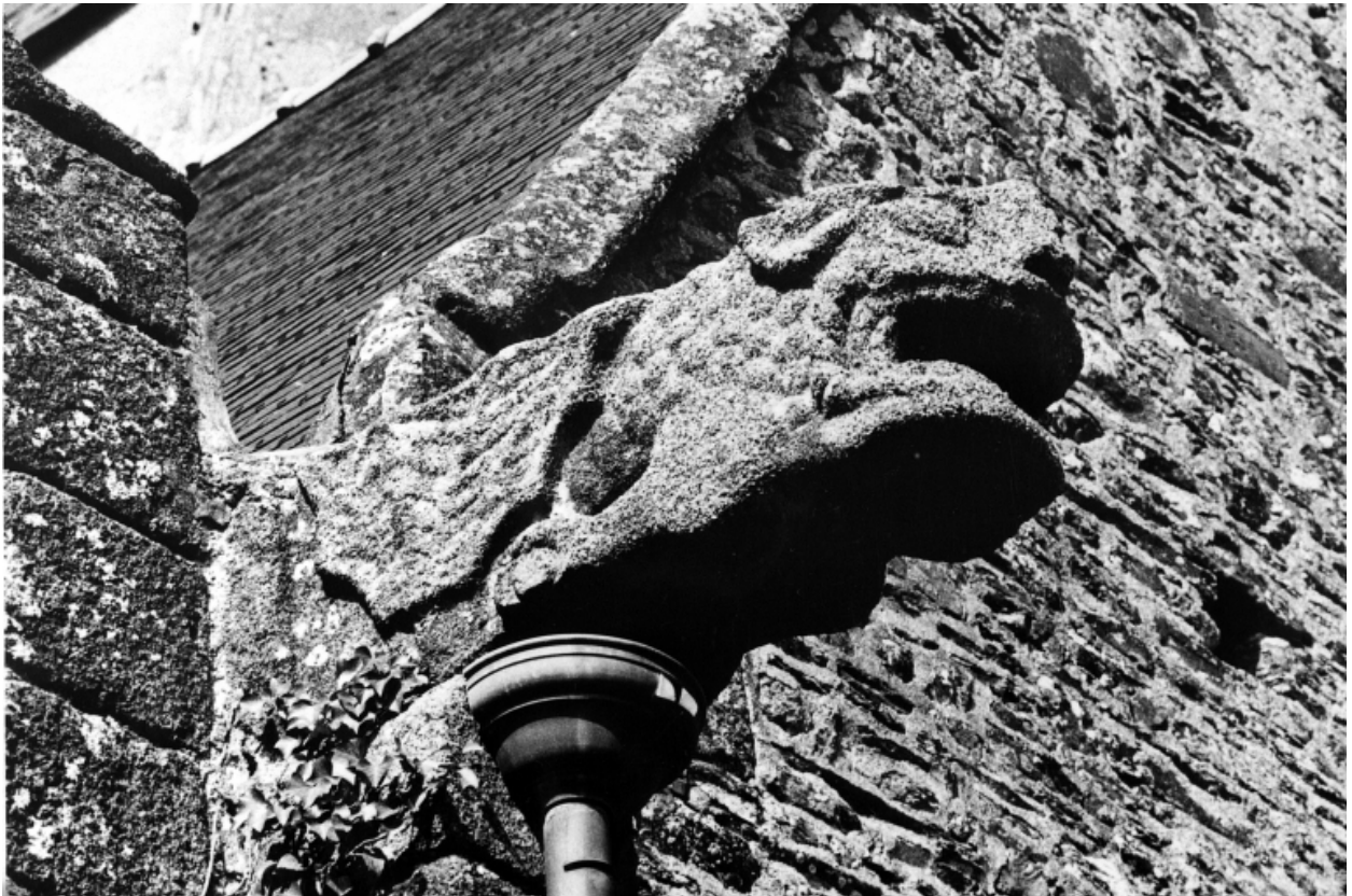
Façade nord, détail gargouille.
