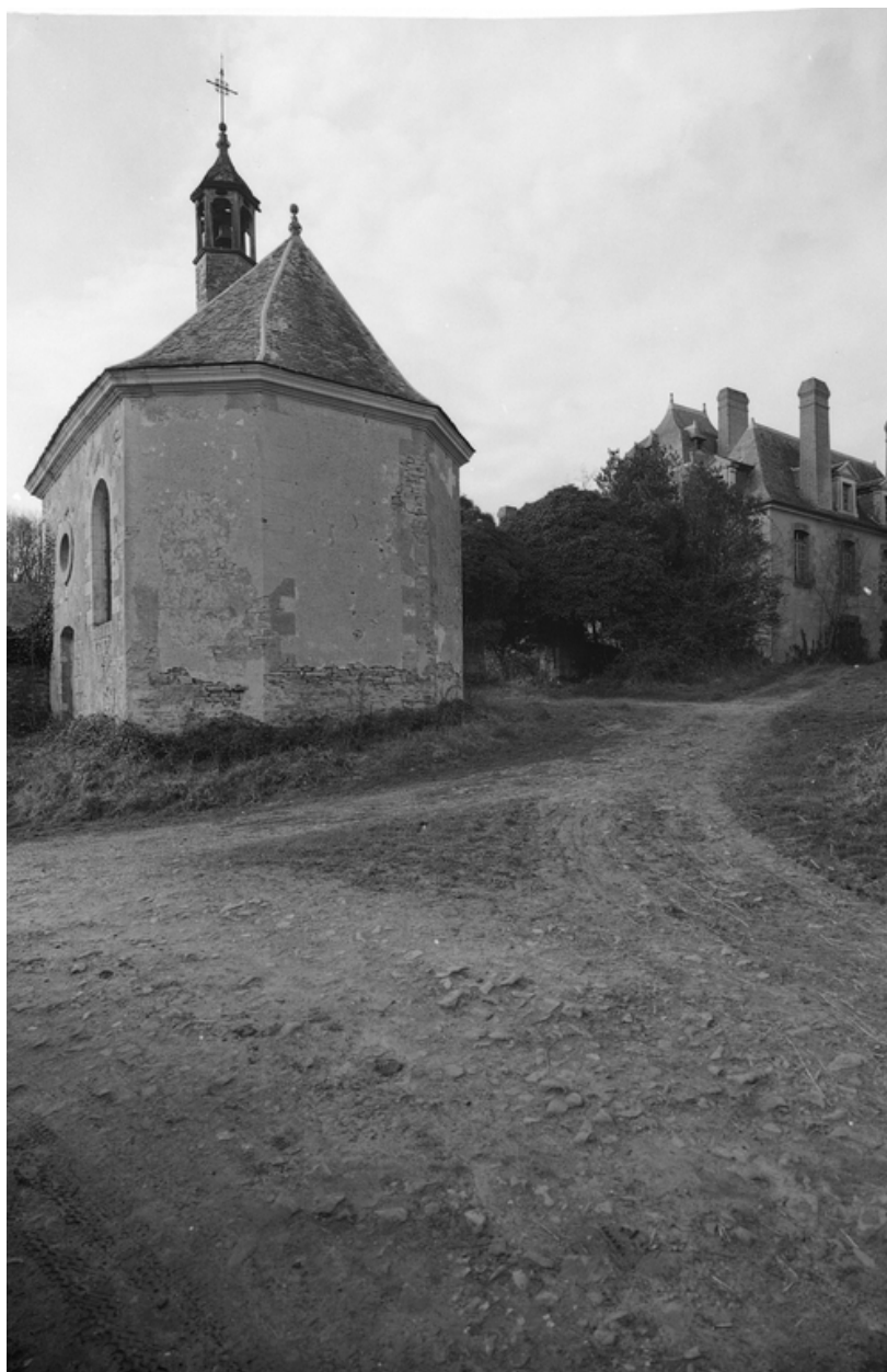
Vue de situation prise du sud-est.
