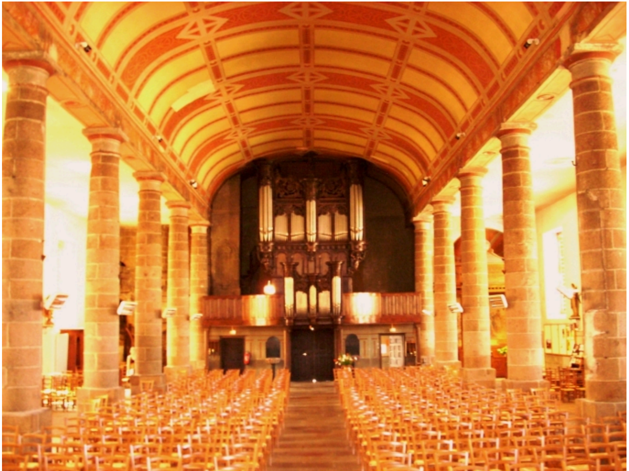
Morlaix, église paroissiale Saint-Mathieu : vue axiale ouest
