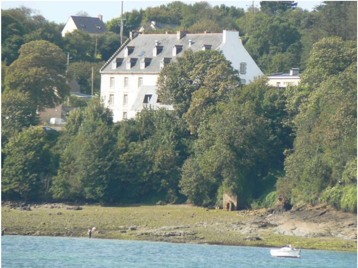
Vue générale de la caserne Sourdis
