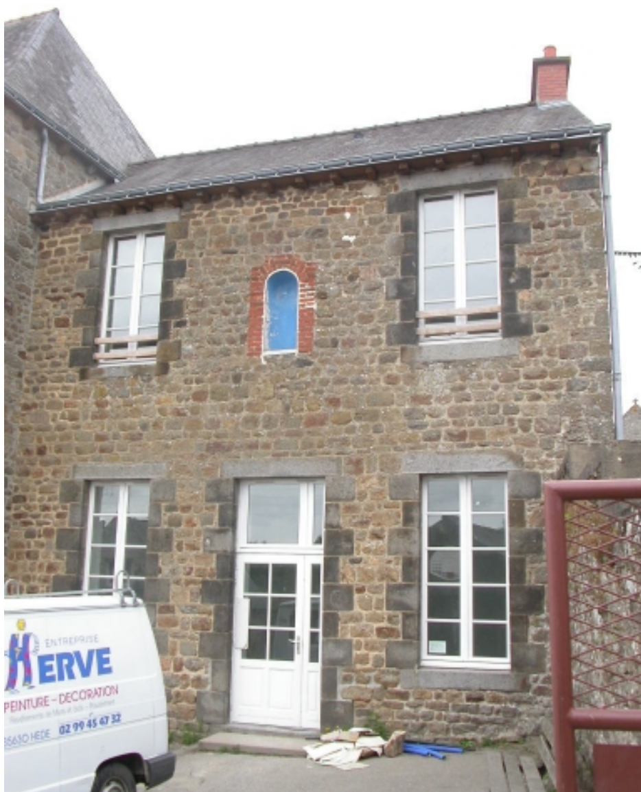
Partie sud, façade ouest
