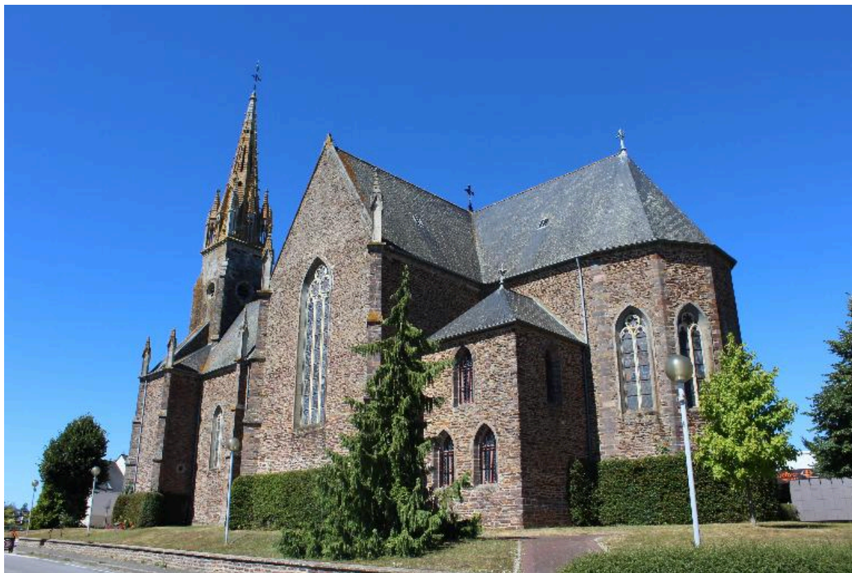
Elévation sud : vue générale
