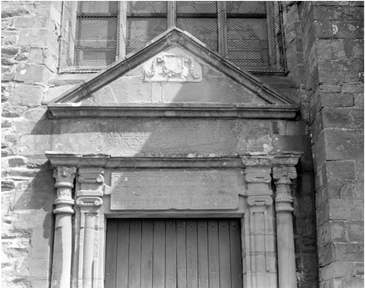
Elévation Sud, porte : détail du tympan
