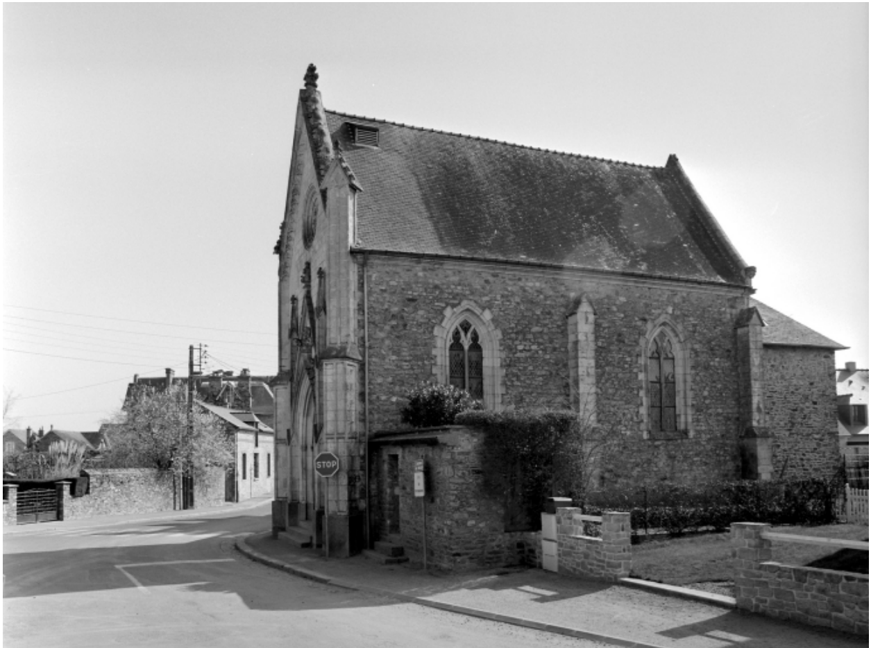
Elévation Ouest : vue générale
