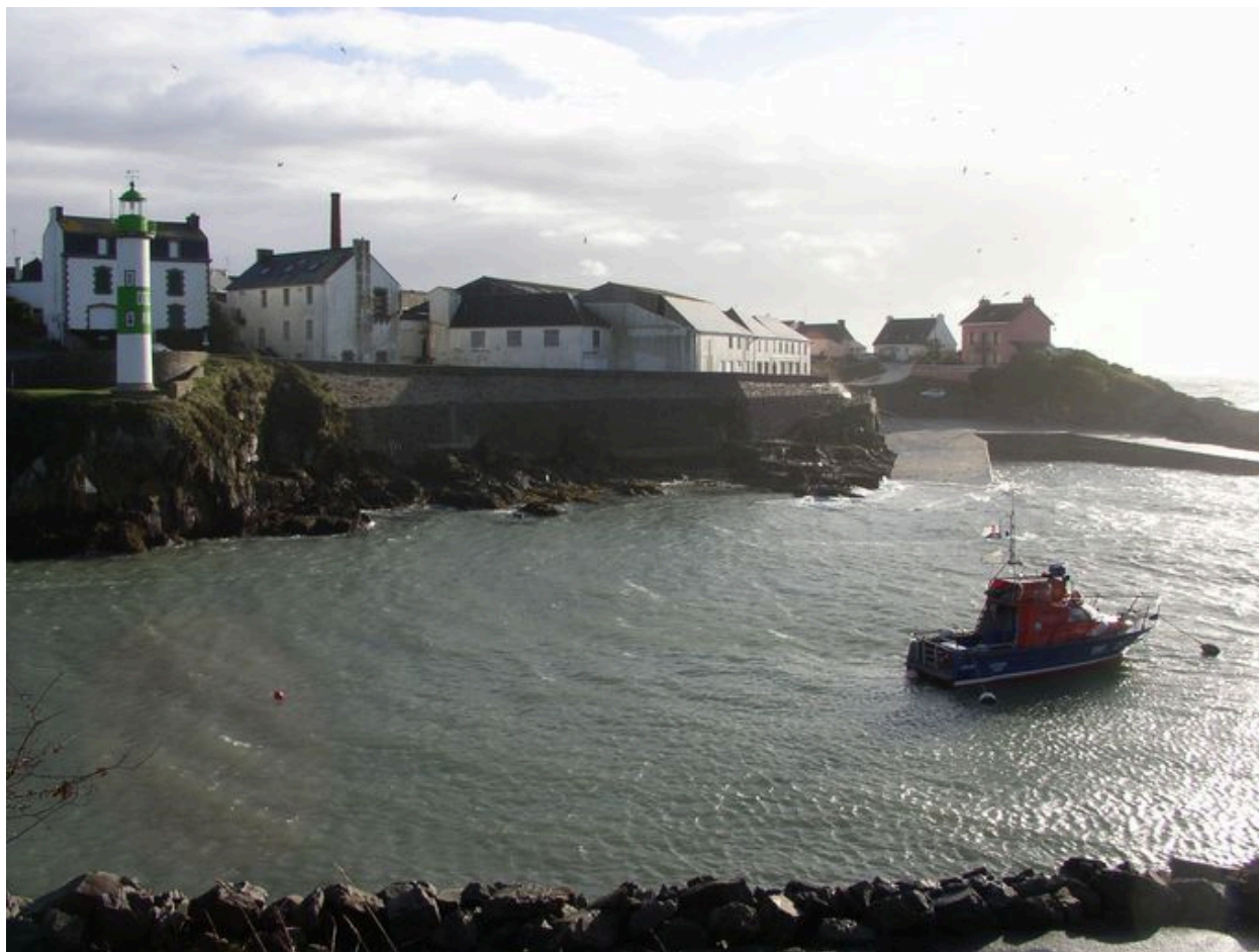
Ancienne conserverie Capitaine Cook vue de la rive droite
