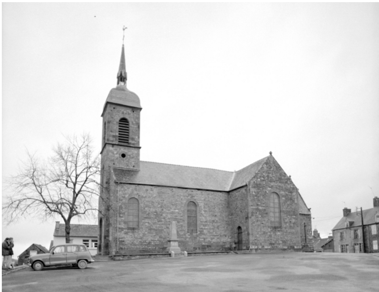
Elévation sud : vue générale
