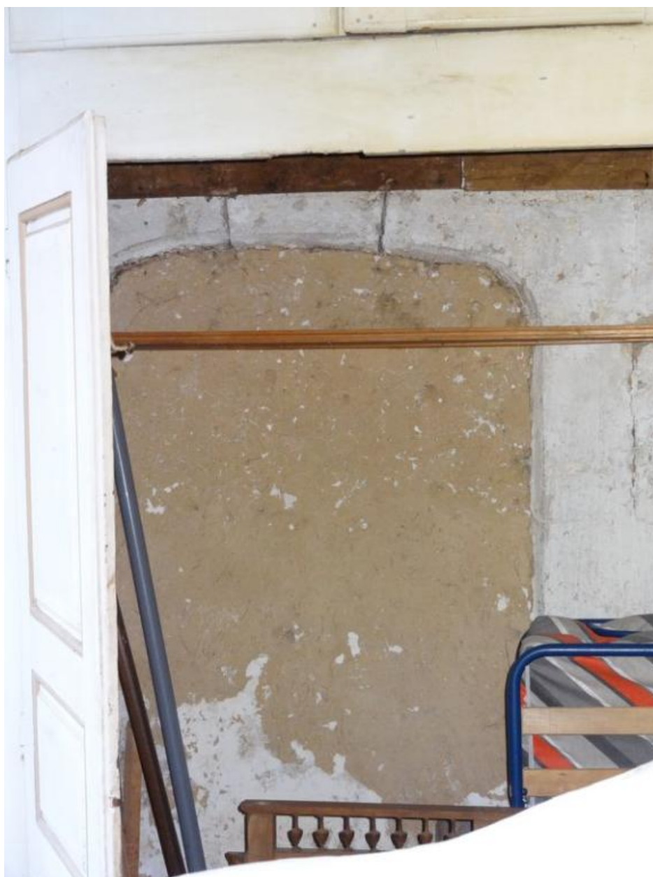
Ancienne porte en anse de panier, mur nord de la pièce centrale du premier étage
