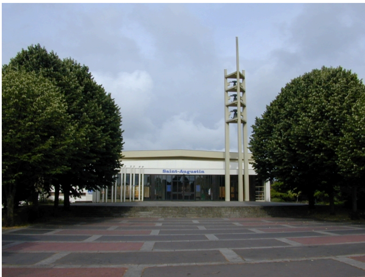
Vue de la façade est
