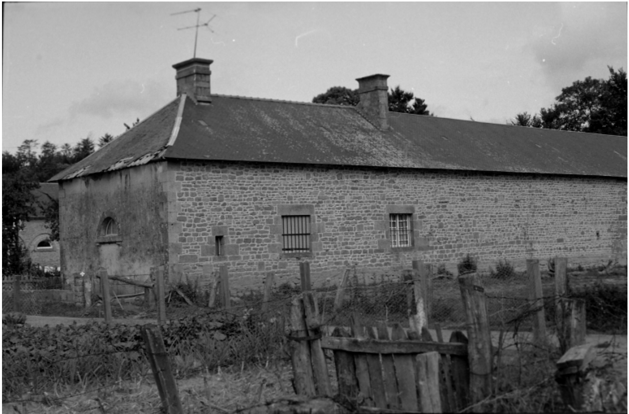
Communs est, façade postérieure.
