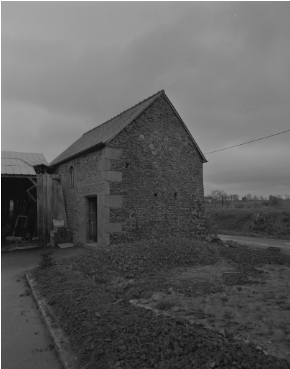
Elévation Ouest : vue générale
