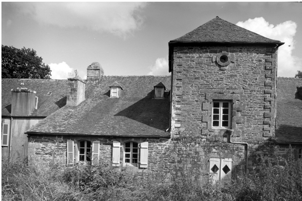
Aile ouest : élévation nord ouest
