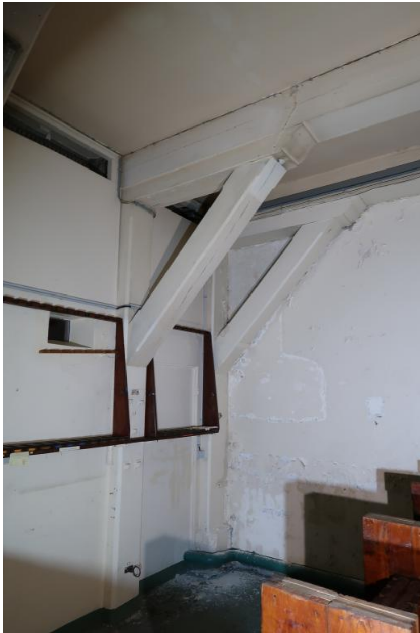
Vue intérieure : partie ouest, rez-de-chaussée, salle d'armes, jambes de force des poutres du plancher du premier étage (état en 2022)
