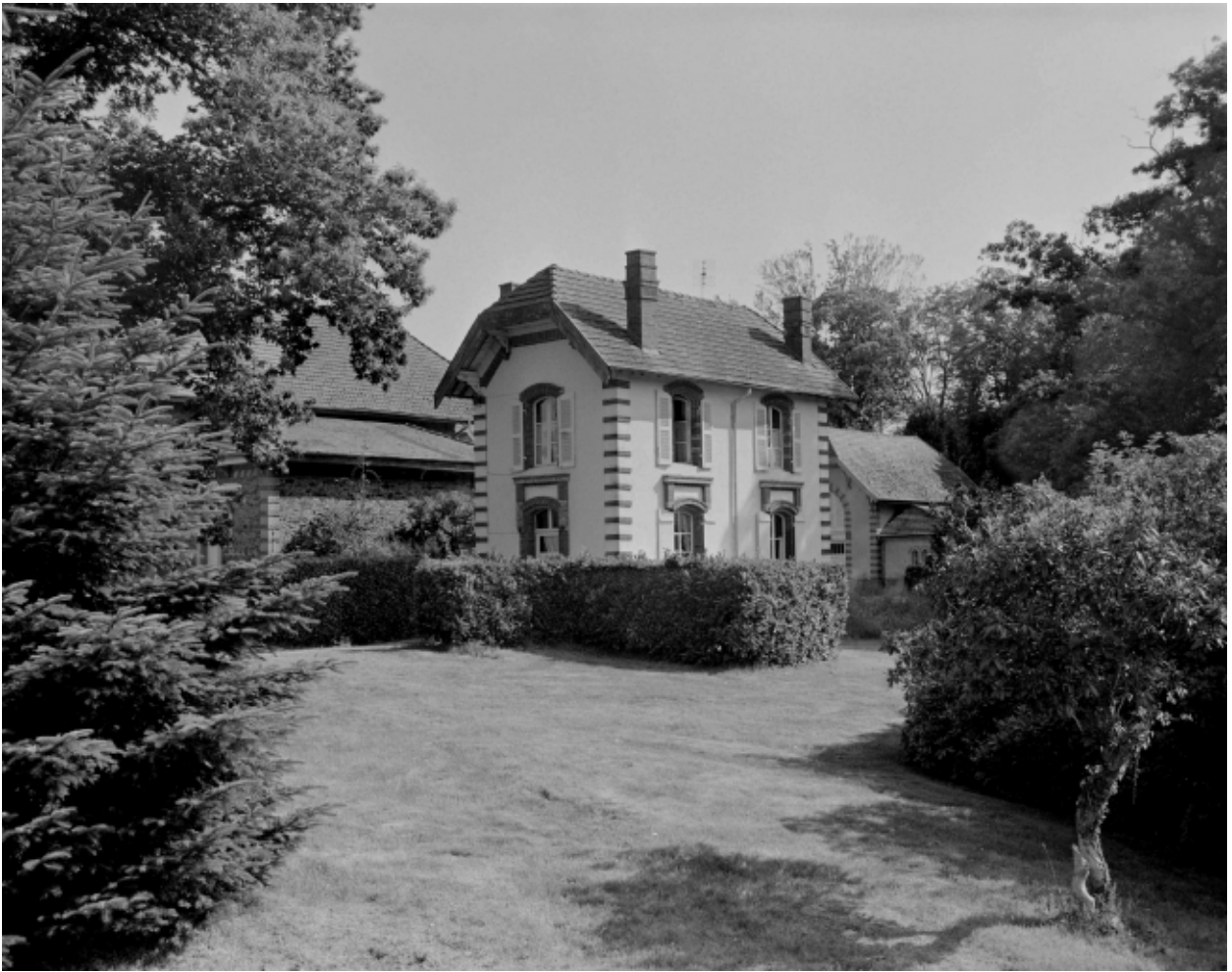
Logement, près de l'ancien chenil
