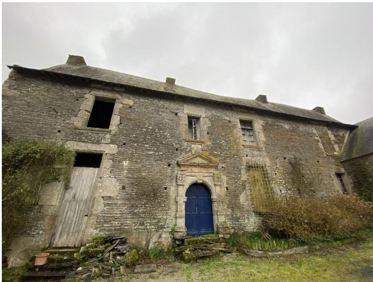
Façade ouest, vue générale
