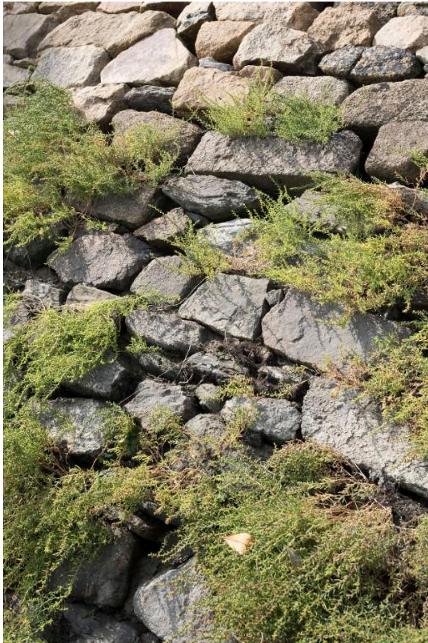
Détail des moellons et de la végétation poussant depuis les interstices de la cale à côté du Pont Noir
