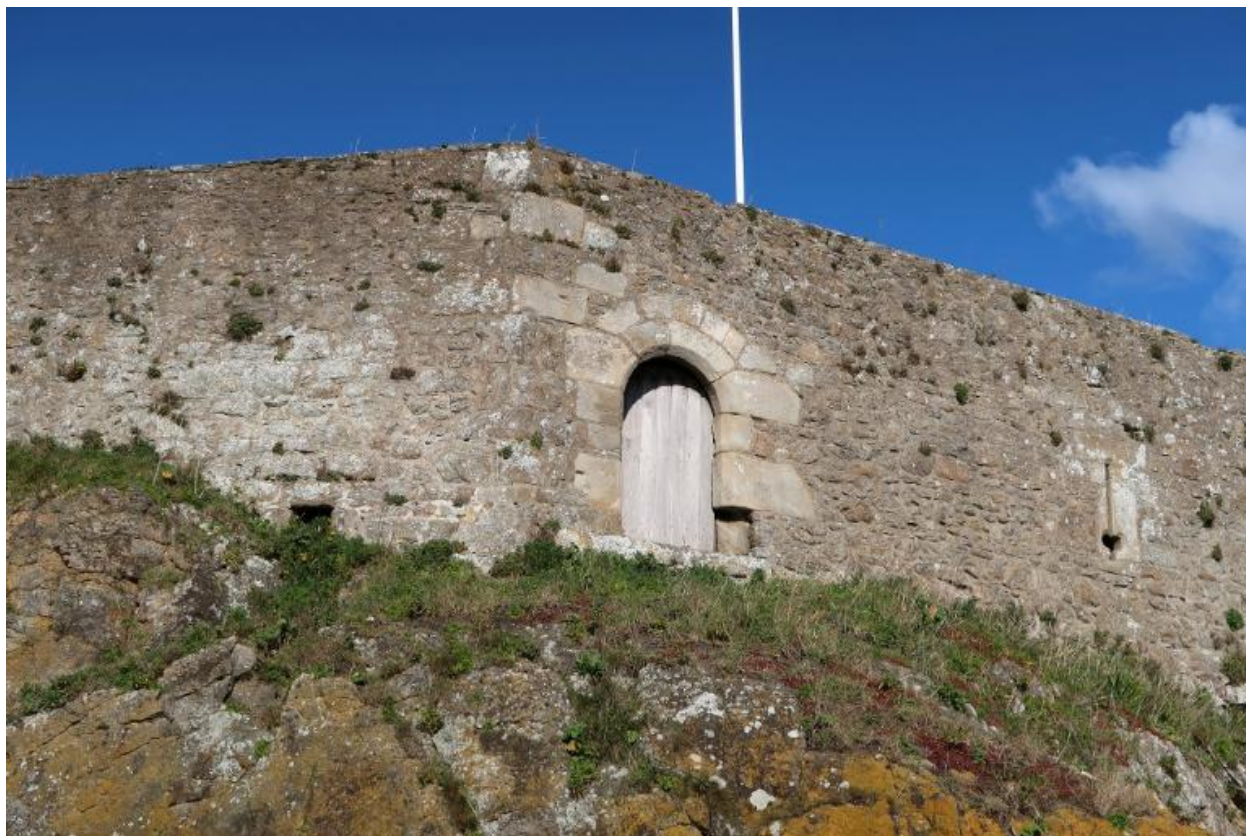
Vue de la basse-cour depuis le sud-ouest : poterne. A droite se trouve une arbalétrière-canonnière
