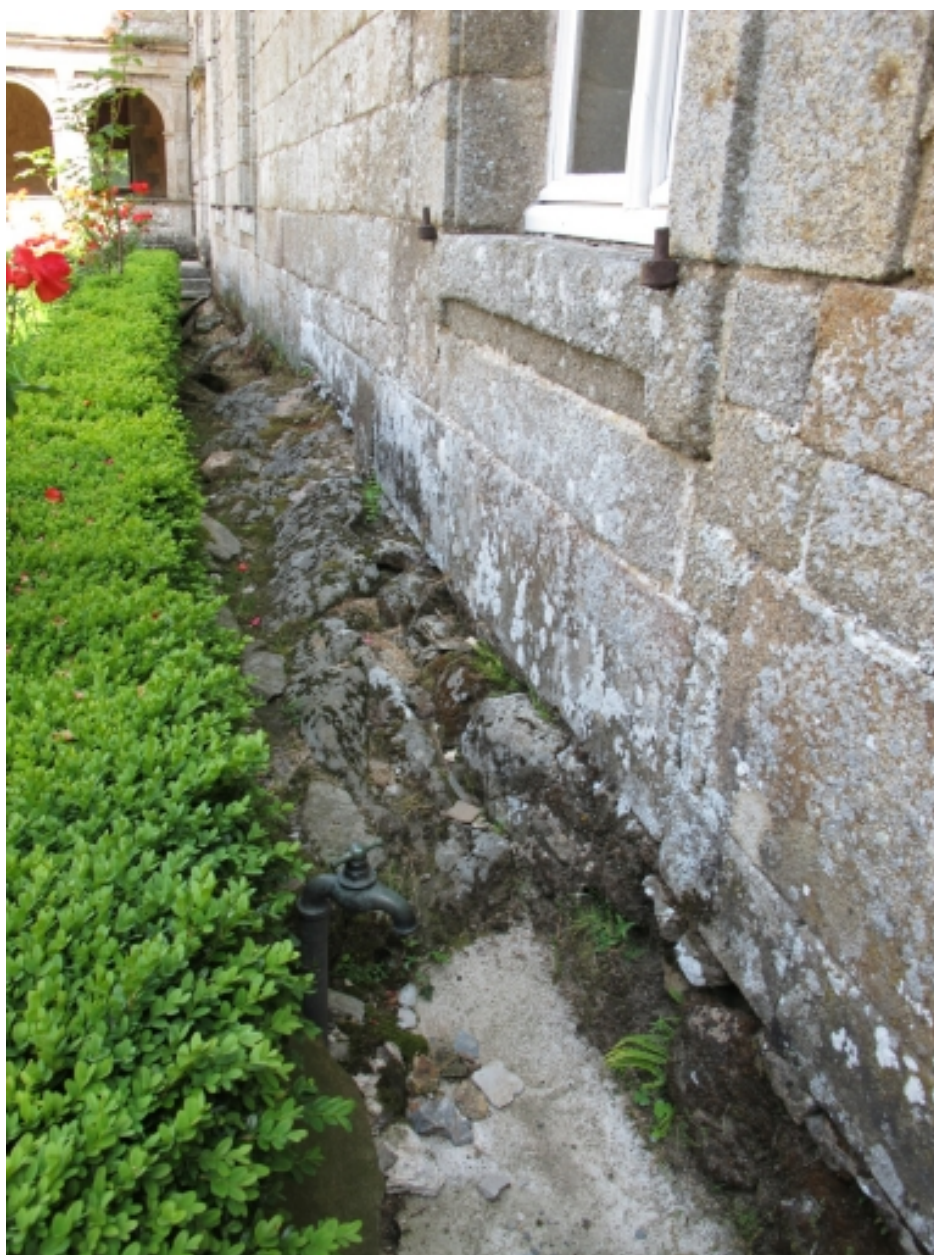
Base du mur, façade principale
