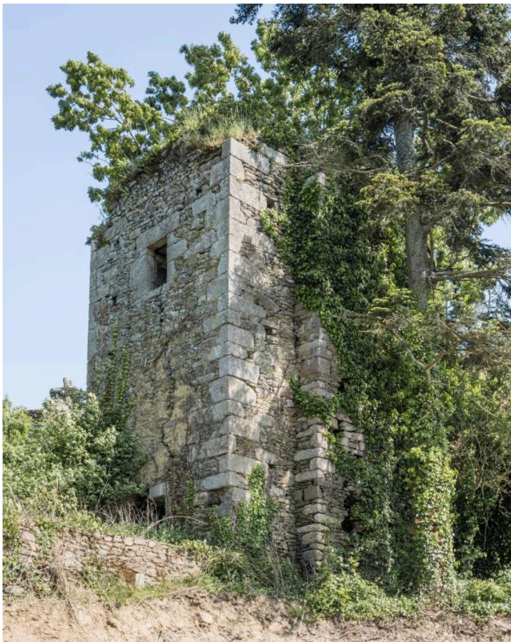
Le château : corps de garde robe arrière ouest
