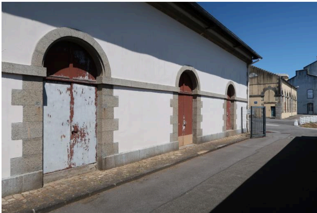
Vue de l'élévation sud (état en 2022)
