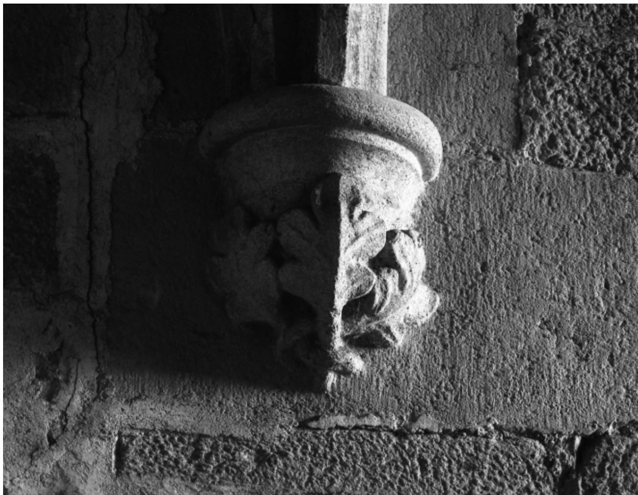
Escalier, palier du 1er étage, croisée d'ogives ouest : détail du cul-de-lampe nord ouest
