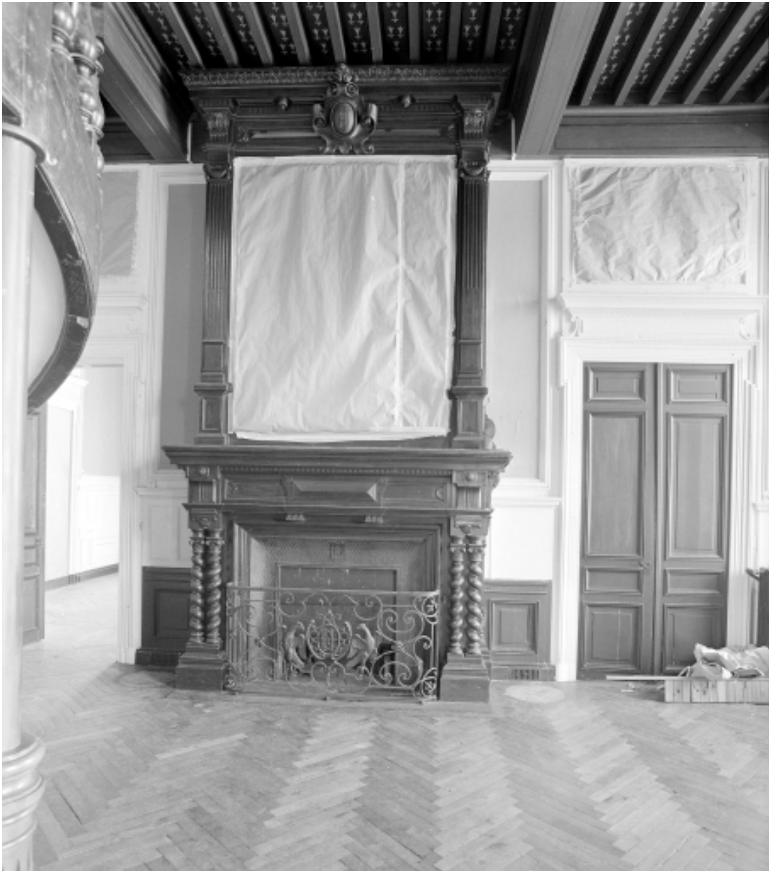
Vue générale de la cheminée de la grande salle.
