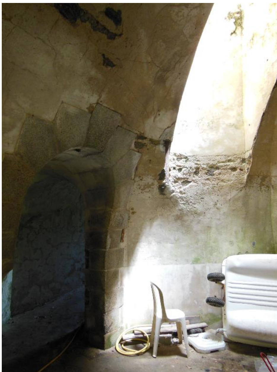
Le Palais, batterie du Gros Rocher, corps de garde crénelé, angle nord-est de la galerie voûtée d'enveloppe.
