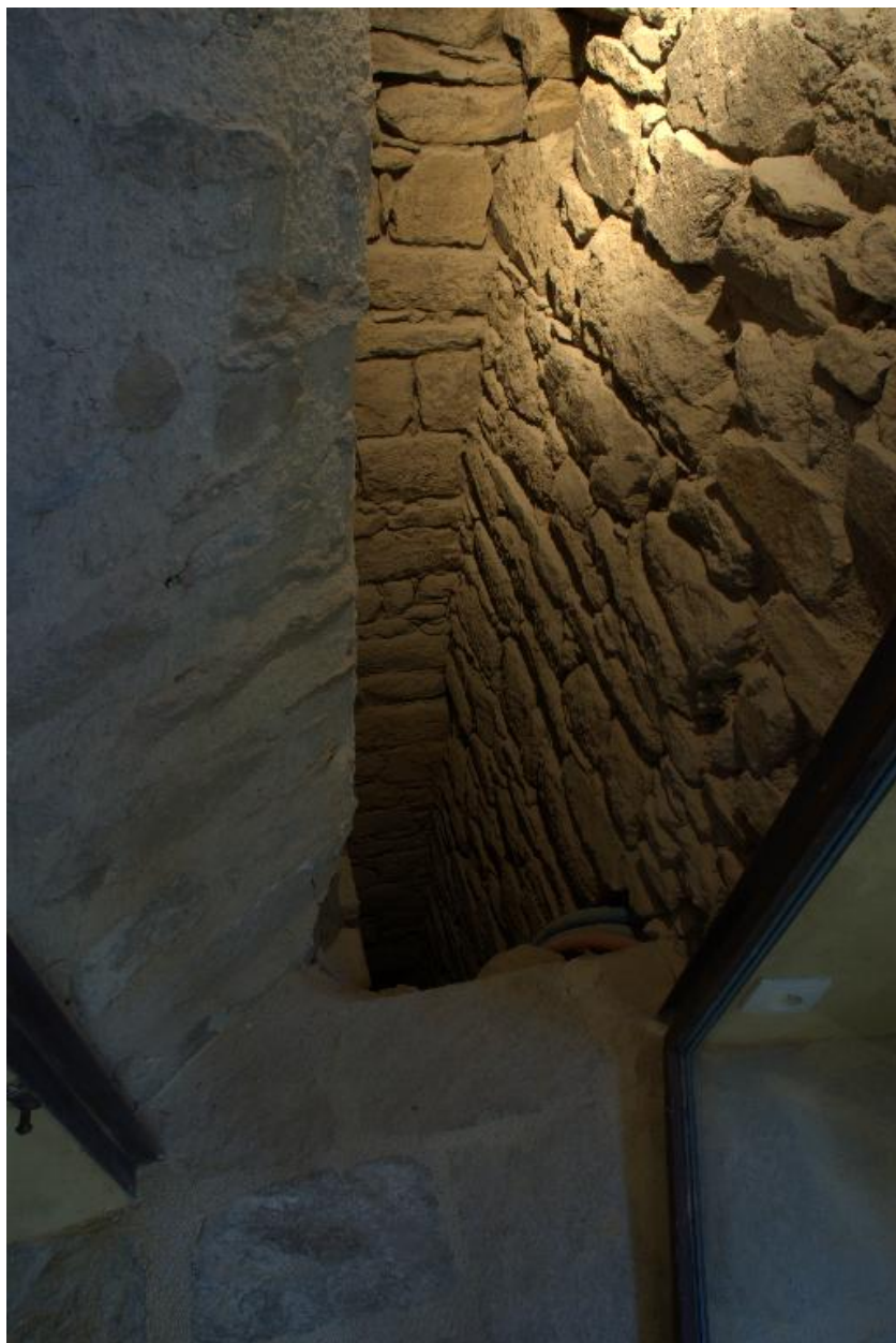
Vue de la fosse des latrines du logis principal
