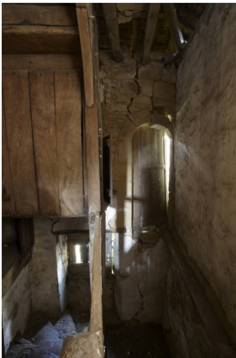
Pavillon, porte menant jadis à une tour au nord, aujourd'hui détruite
