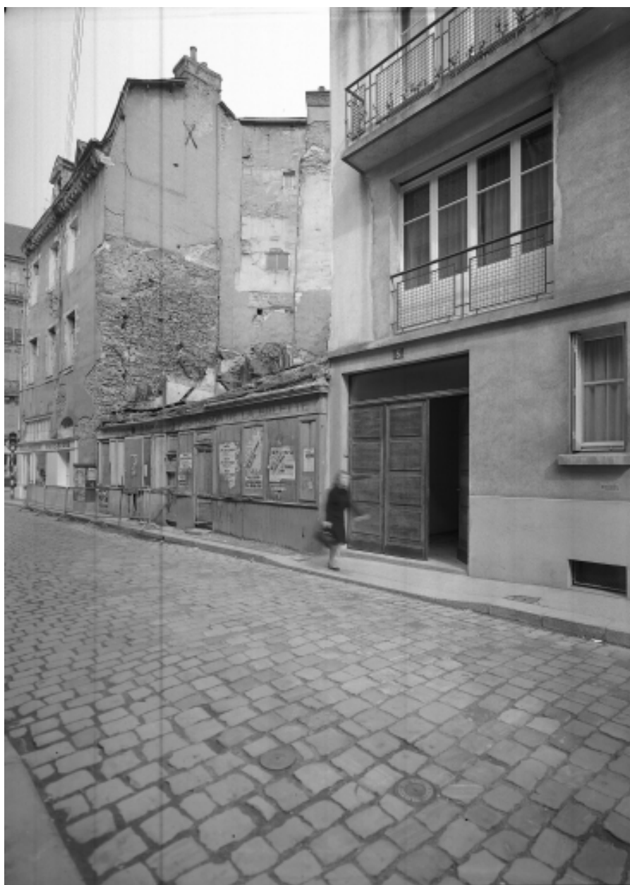
Façade rue Saint-Melaine
