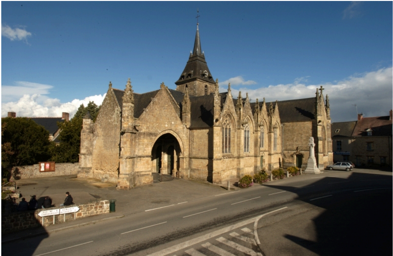
Vue générale sud
