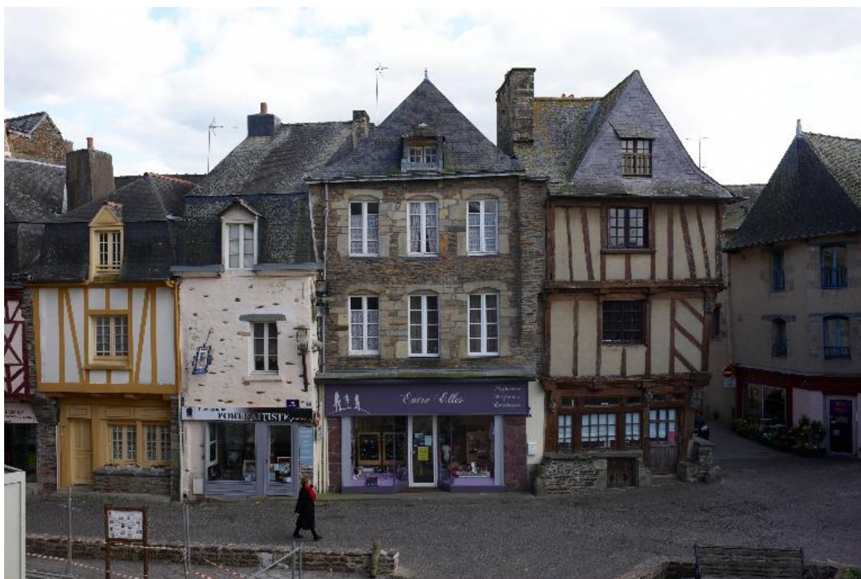
Maison (au centre de l'image) : vue de situation (état en 2012)
