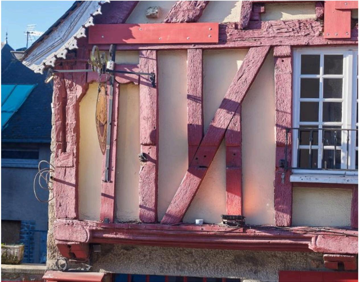
Les mortaises orphelines et trous de chevilles indiquent un appui filant disparu.
