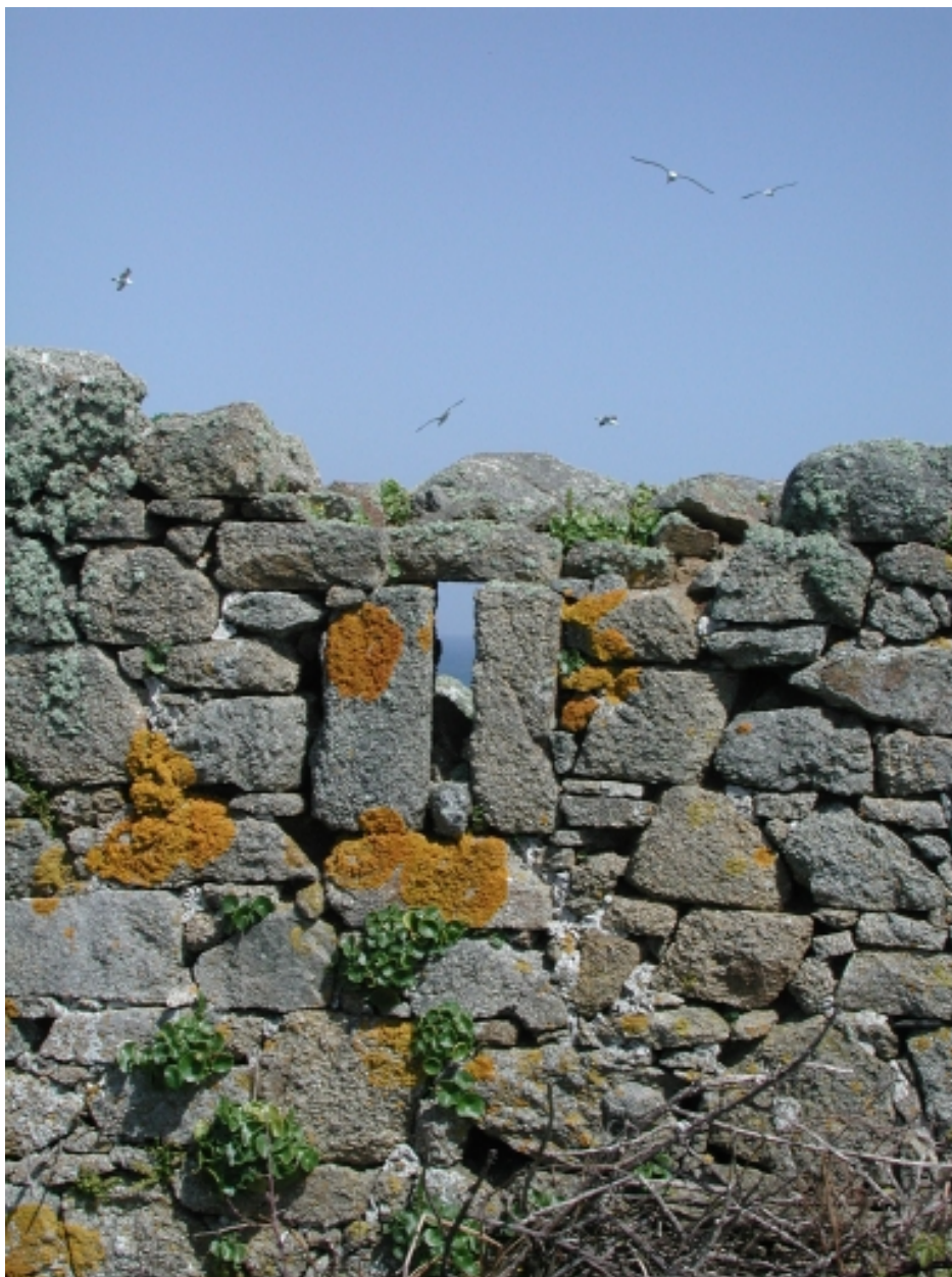
Vue de la meurtrière de la façade sud du corps de garde
