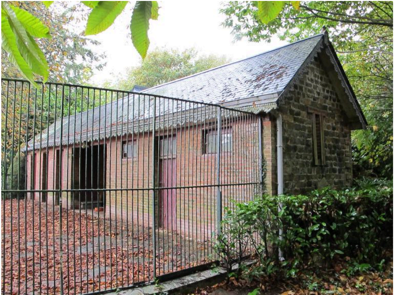
Chenil : vue générale
