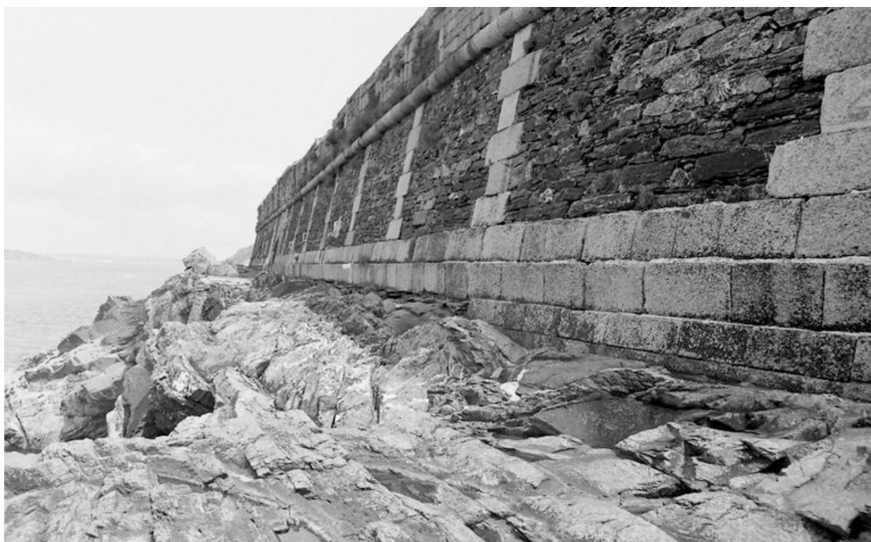
Vue de la batterie de Cornouaille en 1967 : escarpe, chaînes harpées en pierres de taille de granite
