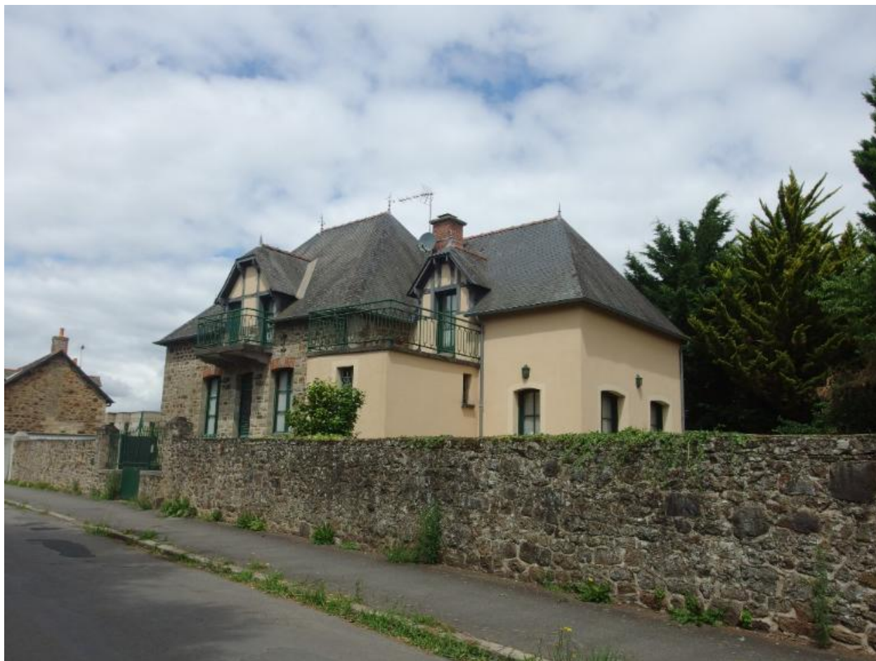
façade sud, rue des quatres Fères Trotoux
