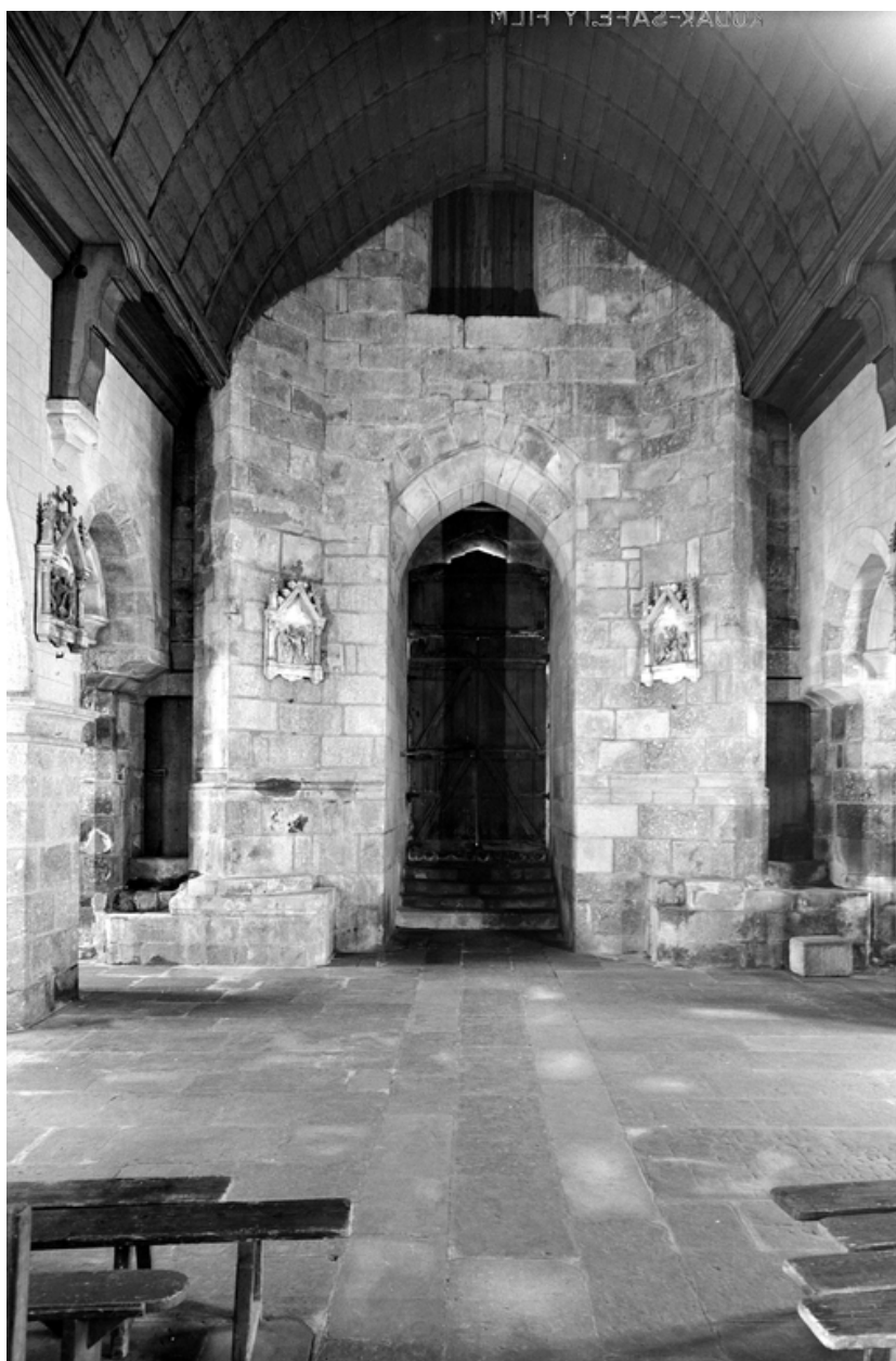
Nef, mur ouest : vue générale
