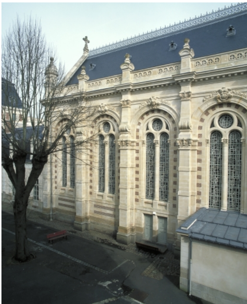
Vue sur la chapelle, cour de la Chapelle
