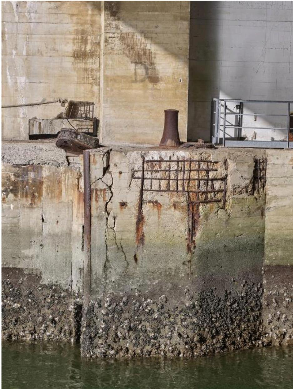
Vue de l'entrée de l'alvéole : quai ouest n° 20 avec cabestan. A signaler : la fixation haute de la porte d'écluse endommagée et la corrosion avancée des fers à béton
