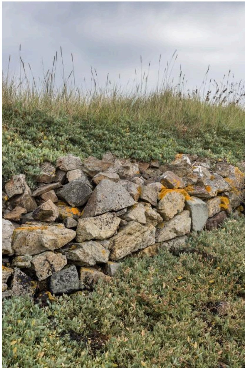
Mur de soutènement bordé par de la végétation de pré salé (obione), situé face au Palud
