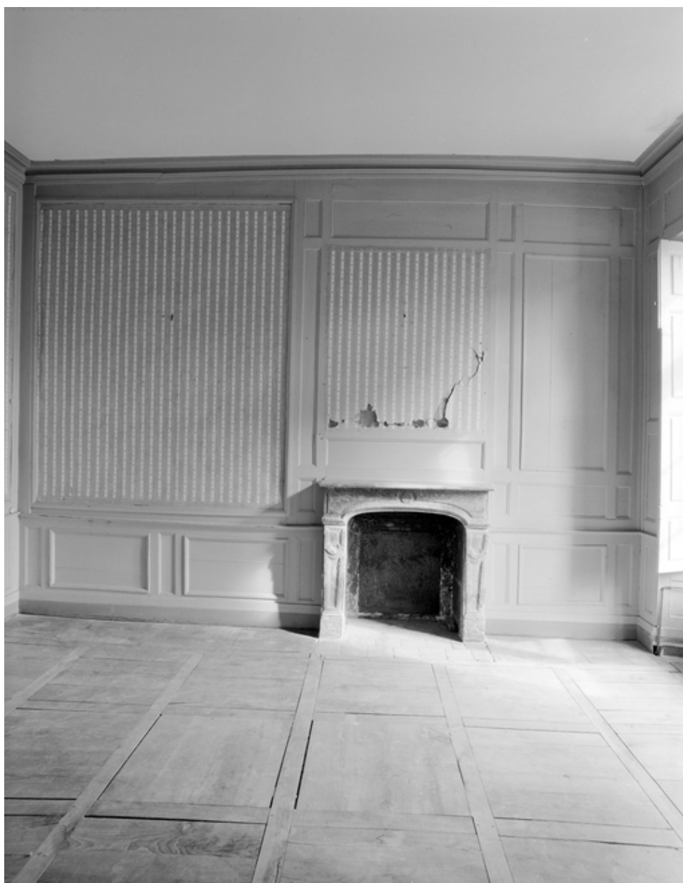
Premier étage, grande chambre sud, mur nord avec lambris et cheminée.
