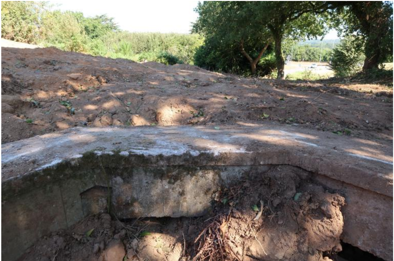
Vue depuis l'encuvement (août 2022, chantier en cours)
