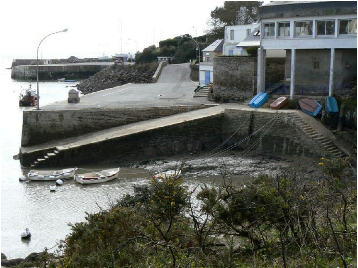
Quai Peyron et deuxième cale vus d'amont
