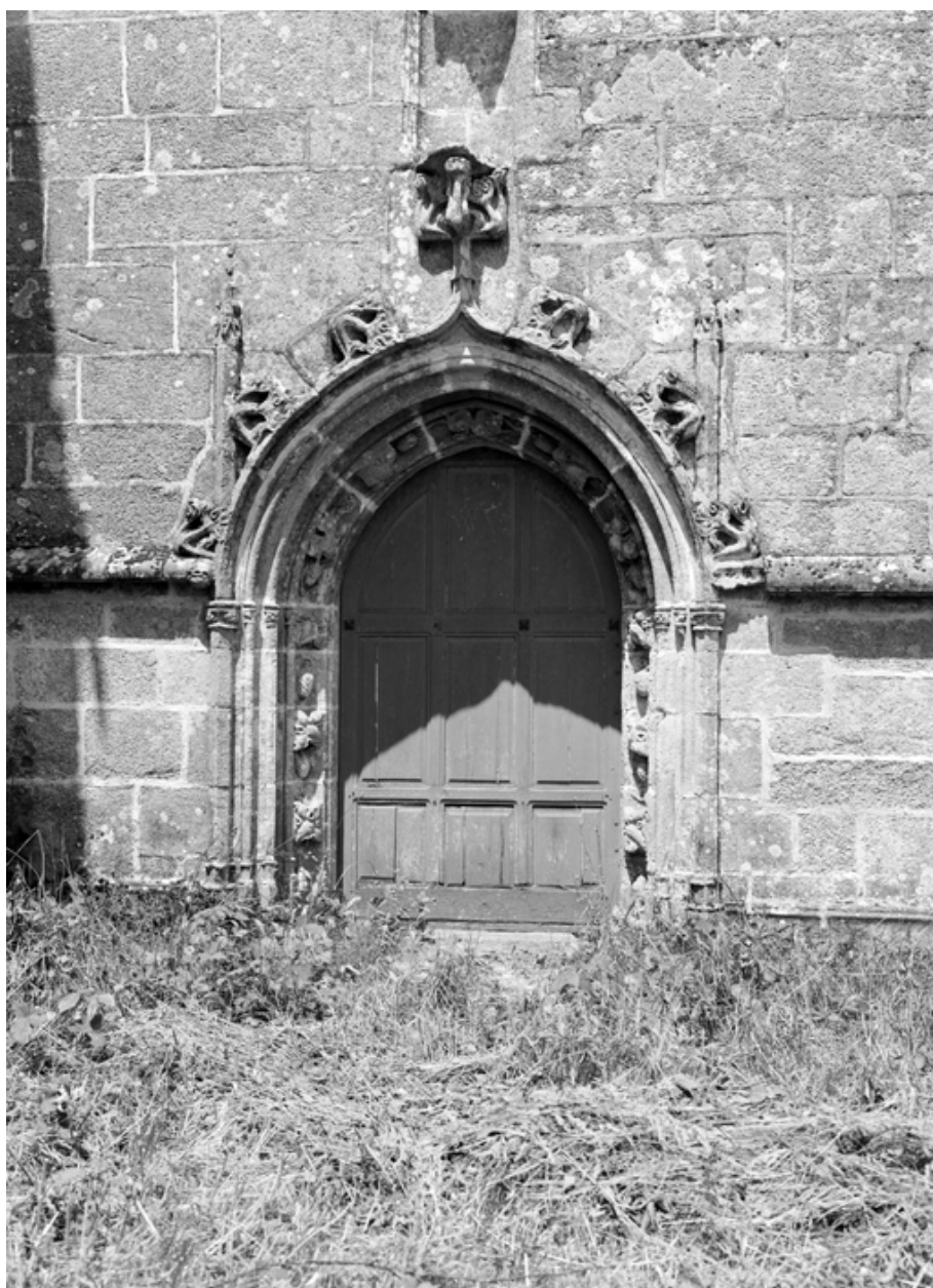
Mur sud du choeur, porte.
