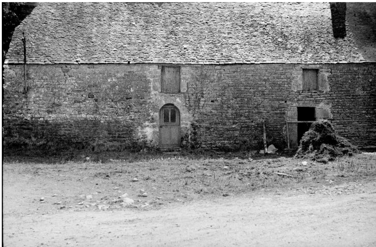
Ferme 51 (état en 1969)
