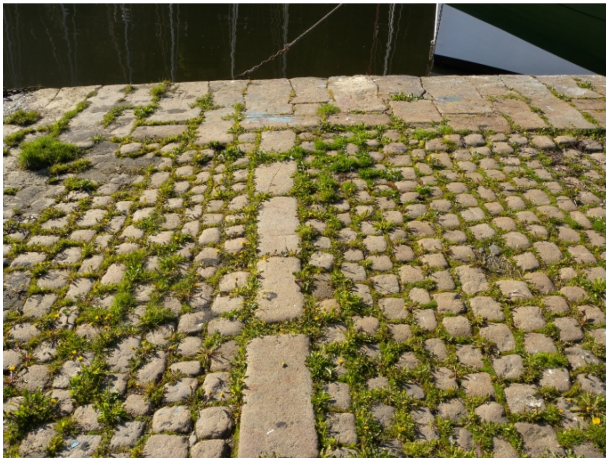
Vue de l'agencement des pavés en granite de la cale d'aval
